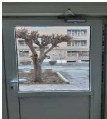
نصب جک های آرام بند
